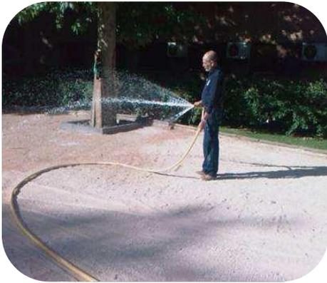
El ratio de dilución empleado perseguirá que con estos dos riegos el suelo haya alcanzado un grado de humedad óptima para conseguir la compactación a densidad máxima
